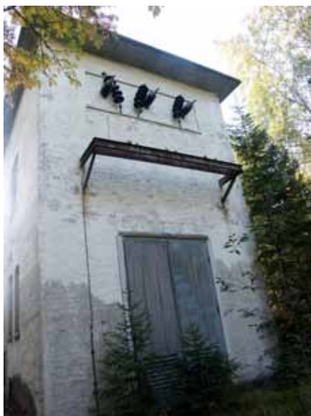
Transformatorstationen på Rävsjär är en del av Norrbyssjärs kulturhistoria
